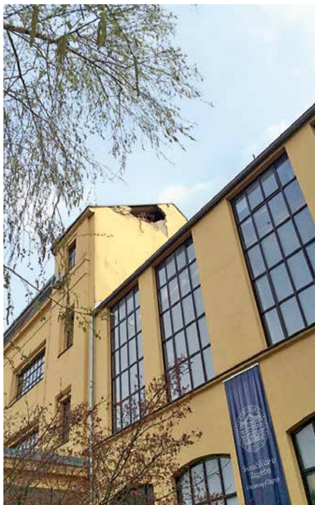
Akademija likovnih umjetnosti - znatno oštećena potresom u ožujku
